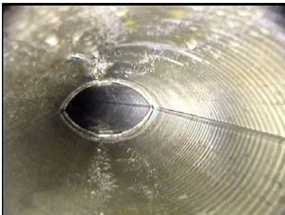
自来水厂管道内检测
