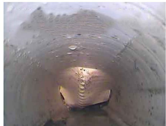
食品加工厂管道内检测
