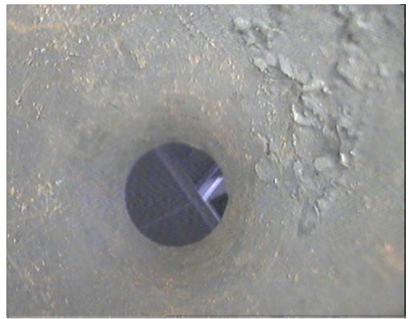
市政排水管道
